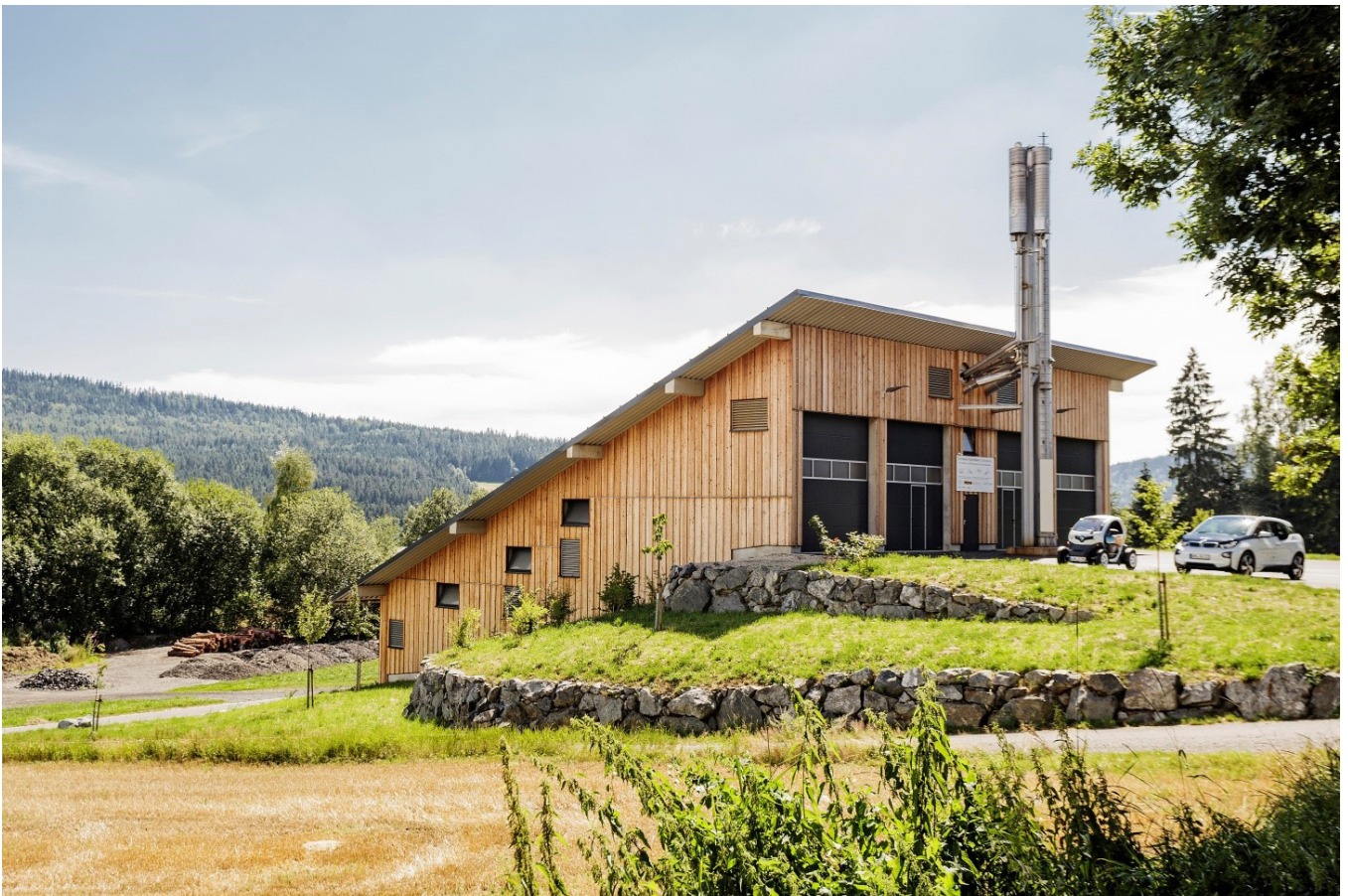
Abb. 18 Nahwärmezentrale Schönbrunn (Stadt Wunsiedel) 4
