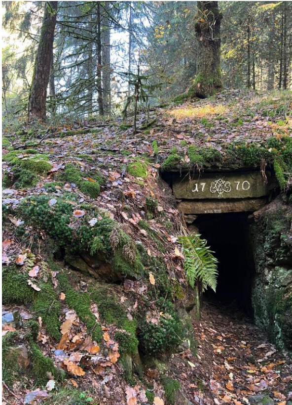
Felsdurchbruch zur Umleitung der Ölschnitz, Foto: P. Hottaß (2024)
