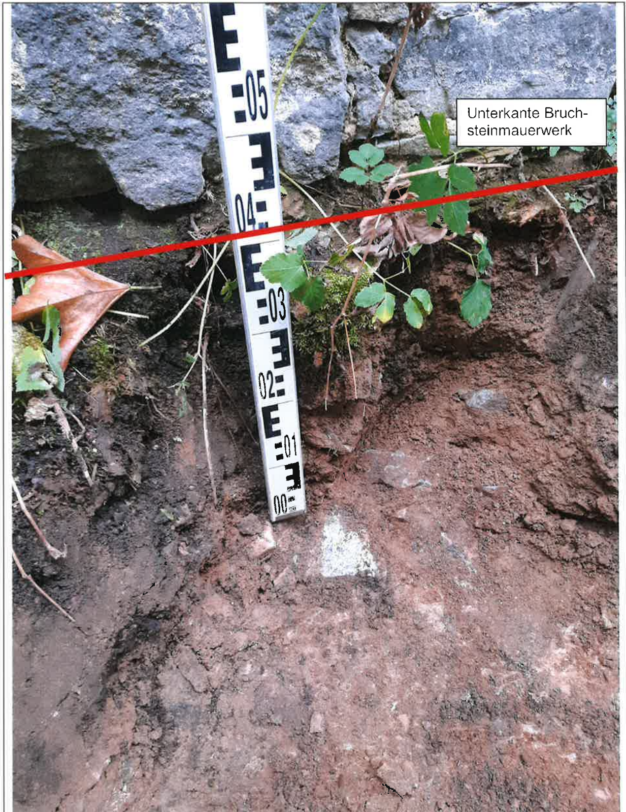
Bild 4: Detailbild Aufgrabung Sch2, Hauptgebäude Hofer Str. 79
