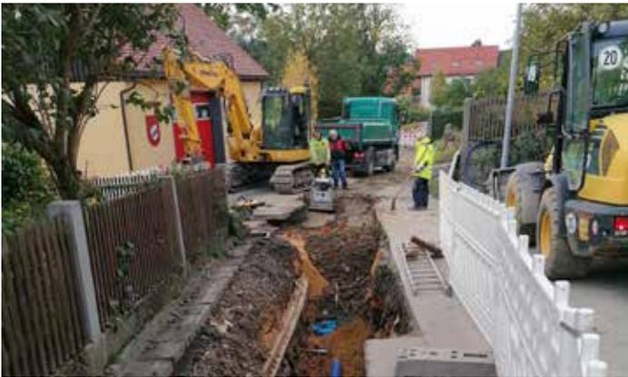
Die Bauarbeiten an der Wasserleitungsauswechslung mit Straßensanierungsarbeiten im Gefreeser Ortsteil Metzlersreuth sind in vollem Gang. Die Bauarbeiten hat die im Vogtland ansässige Firma Oelsnitzer Bau & Service GmbH übernommen.
