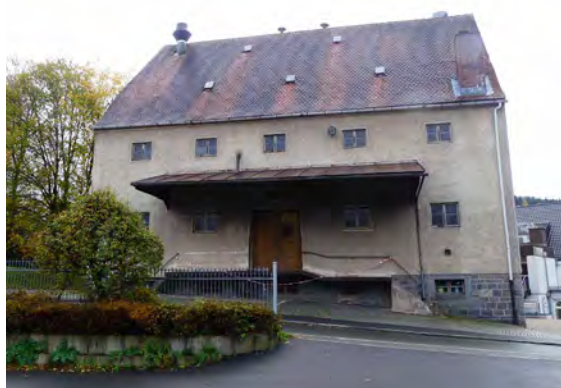
Abb. 97 Fassade Nord des Leerstandes
