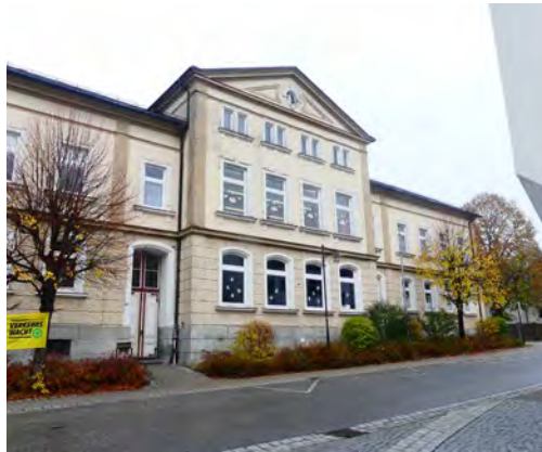
Abb. 99 Fassade Alte Grundschule
