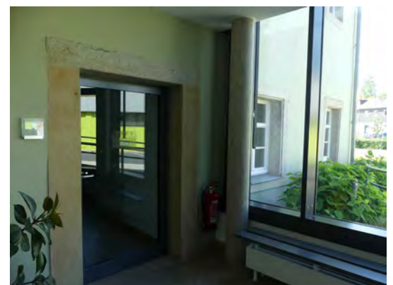
Abb. 96 Innenraum - Verbindung alt - neu
