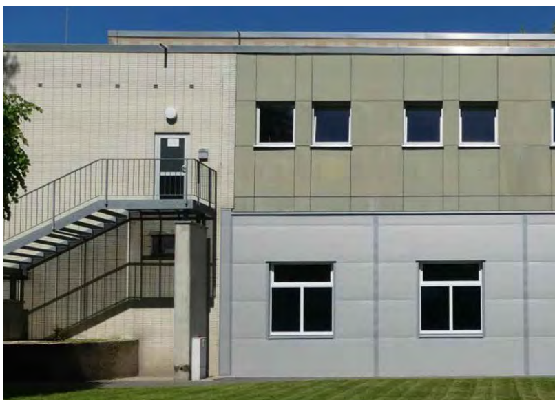
Abb. 63 Teilweise überarbeitete Fassaden an der Südseite
