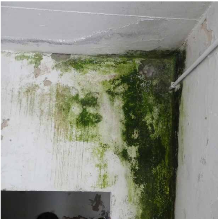
Abb. 66 Eine von vielen nassen Stellen im Gastrotrakt
