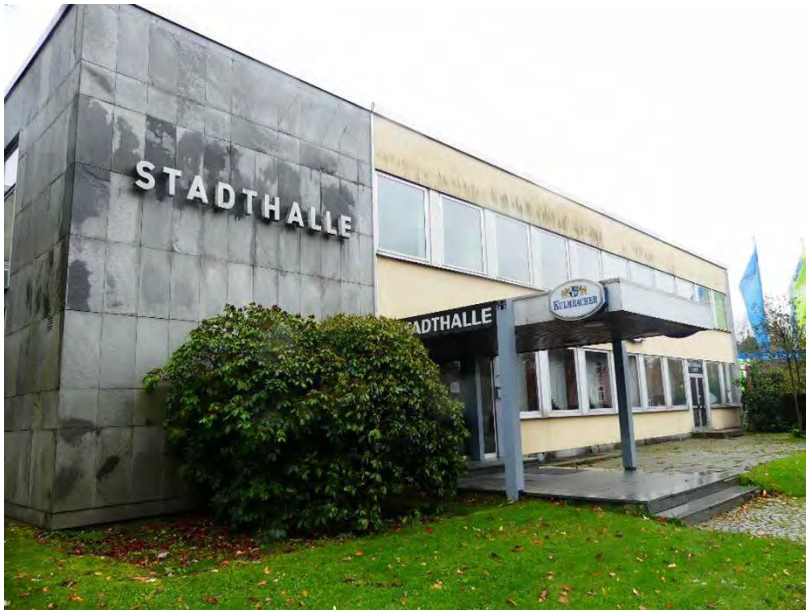
Abb. 62 Naturstein- und Putzfassade entlang der Hauptstraße
