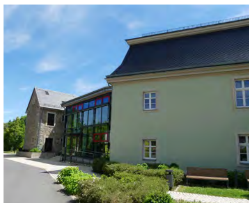
Abb. 95 Fassaden beispielhaft saniertes Gebäude
