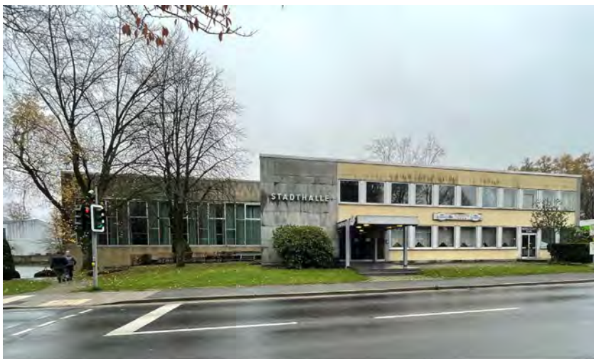
Abb. 138 Bestandsfoto von der Hauptstraße
