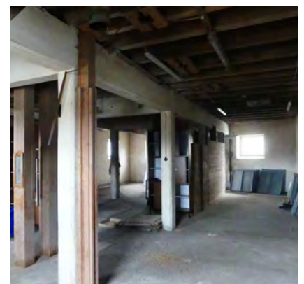
Abb. 98 Solide Innenraumstützen in gutem Zustand
