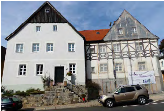
Abb. 34 Ansicht Nachbargebäude Süden
