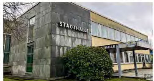
Die Stadthalle – von einem Abriss ist man abgerückt. Foto: Judas
