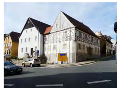
Abb. 90 Knotenpunkt Hofer Str. 1+3
