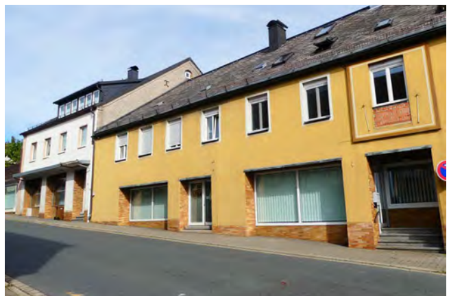
Abb. 63 Gegenüber Hofer Str. 1+3 (Leerstände)
