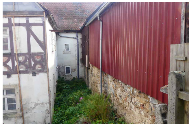
Abb. 33 Freifläche als Fuge zum Nachbargebäude (neu sanierte Scheune der Hauptstr. 79), evtl. Standort für Lift?
