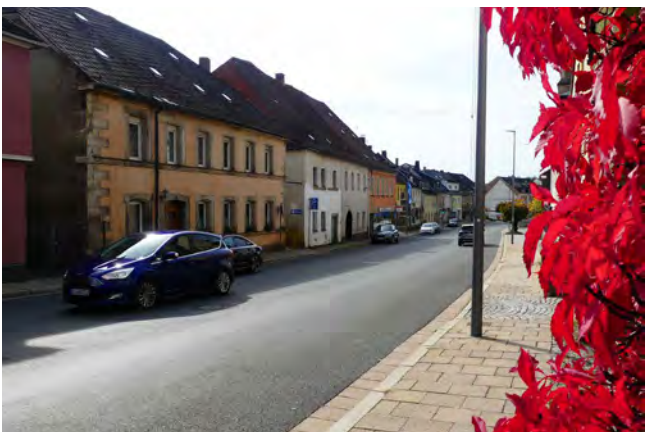
Abb. 62 Blick zur Hauptstraße von Hofer Str. 1
