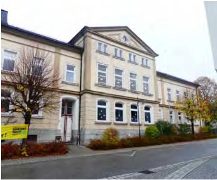
Abb. 05 Fassade Alte Grundschule
