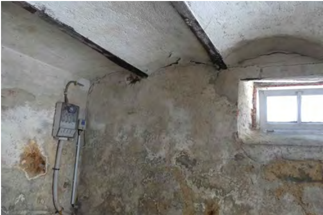
Abb. 52 Kellerraum preußischen Kappendecken
