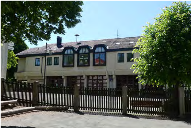
Abb. 64 Feuerwehr und Haus der Begegnung
