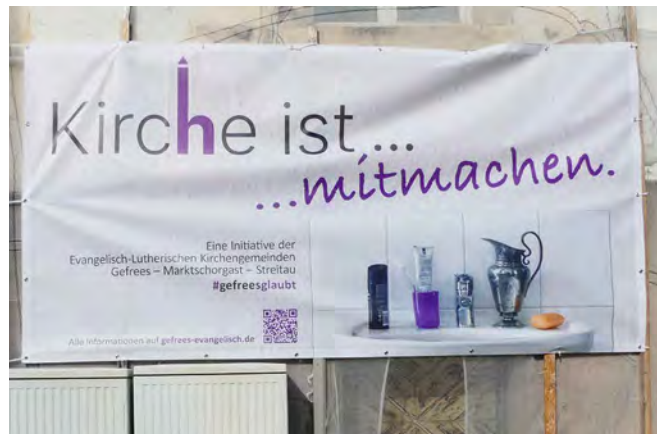
Abb. 39 der Straße zugewandte Südfassade mit „Interessensbekundung“
