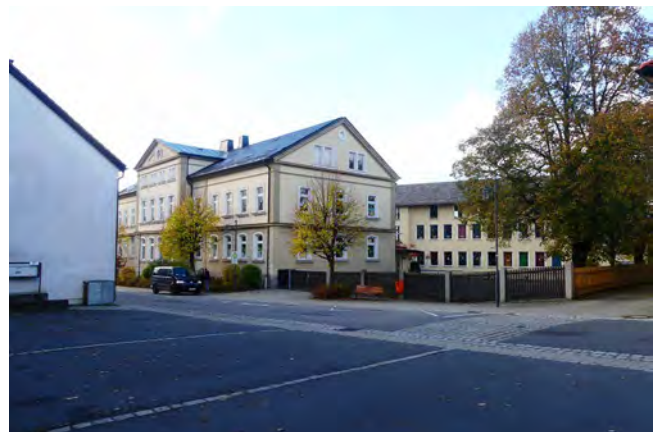
Abb. 69 Grundschule, demnächst Leerstand Altbau im Vordergrund „Neubau“ 1960er-Jahre im Hintergrund
