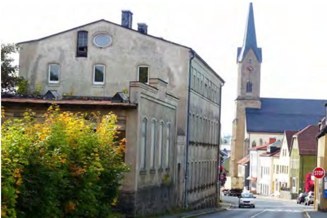
Abb. 60 Verwaltungsgebäude Rogler, links im Bild, im Hintergrund Kreuzung Hofer Str. 1+3
