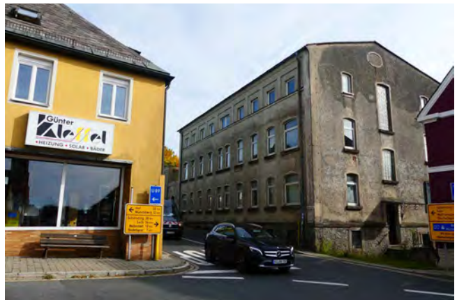
Abb. 61 Verwaltungsgebäude Rogler im Süd-Osten
