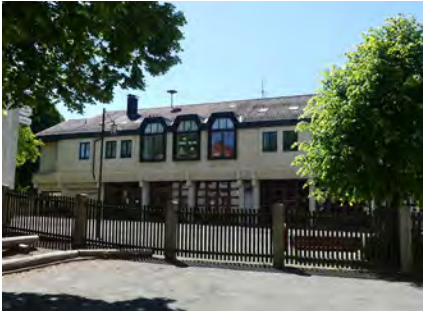
Abb. 11 Haus der Begegnung und Feuerwehr
