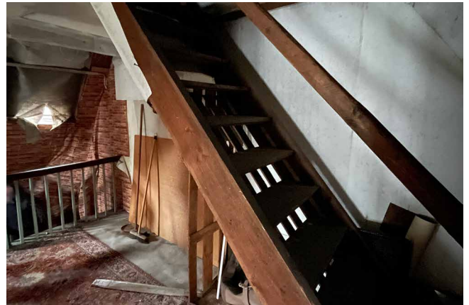
Abb. 49 Zugang zum Dachboden
