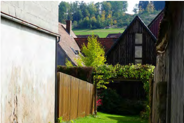
Abb. 58 rückwärtige Erschließungssituation Nachbarhaus (Hauptstraße 79) von der Schulstraße
