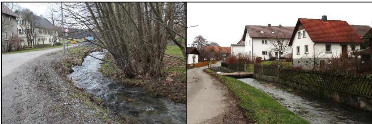
Abbildung 126: Hochwasserrisiko durch den Bachverlauf in Metzlersreuth
