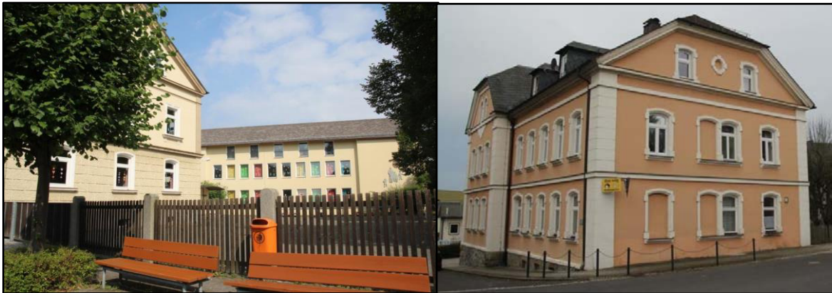
Abbildung 13: Die Grundschule in Gefrees (links) und der Kindergarten in Streitau (rechts)
