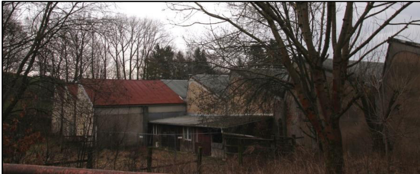
Abbildung 138: Die Industriebrache in Streitau
