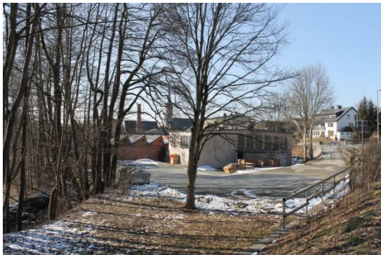
Ansicht von Süd-Osten
