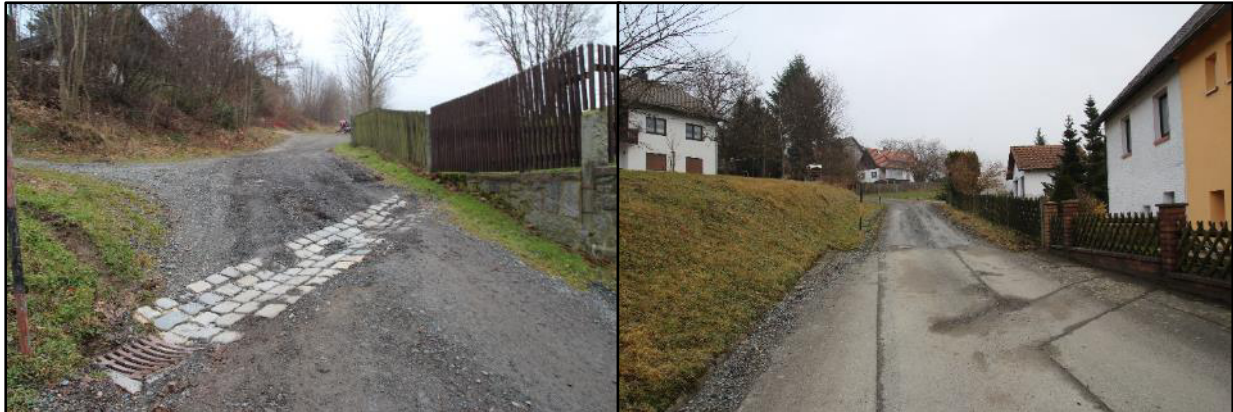
Abbildung 130: Straßenschäden durch Oberflächenwasser in Schamlesberg
