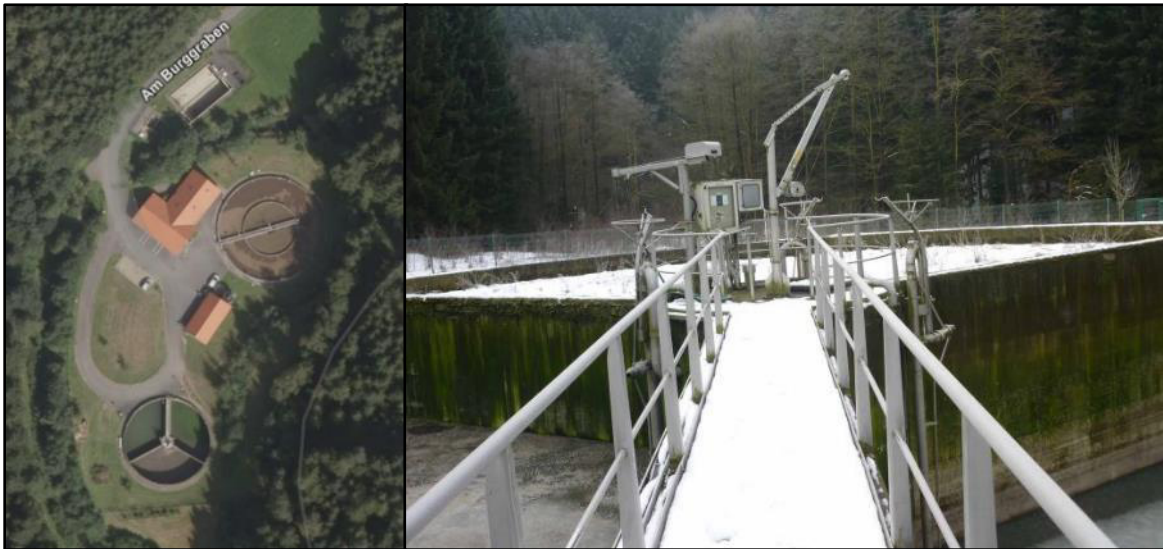
Abbildung 82: Luftbildaufnahme der Kläranlage (links) und der Schlammfelder (rechts)
