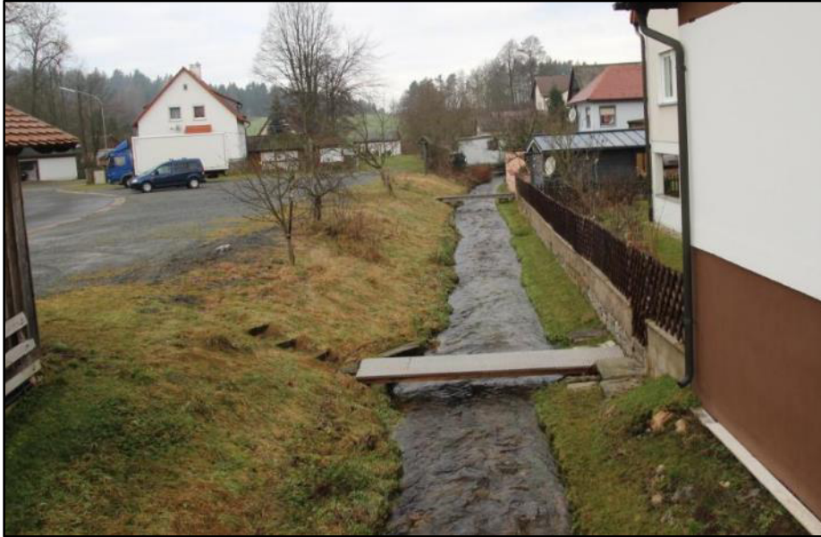
Abbildung 117: Verlauf des Kornbachs entlang der Häuserzeilen
