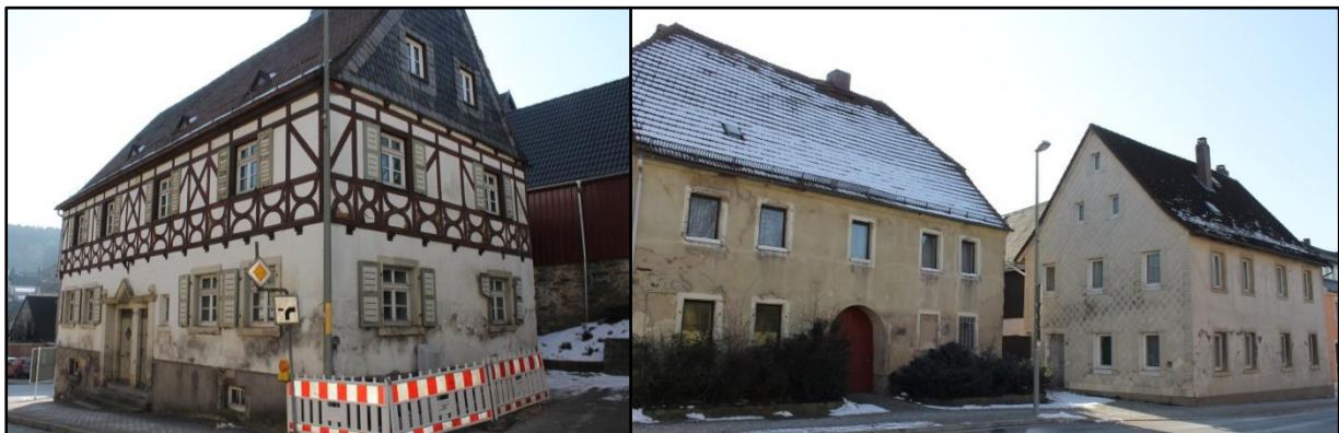
Abbildung 55: Einzeldenkmal und Leerstand in der Hofer Straße (links), Leerstände und Sanierungsbedarfe in der Hauptstraße (rechts)
