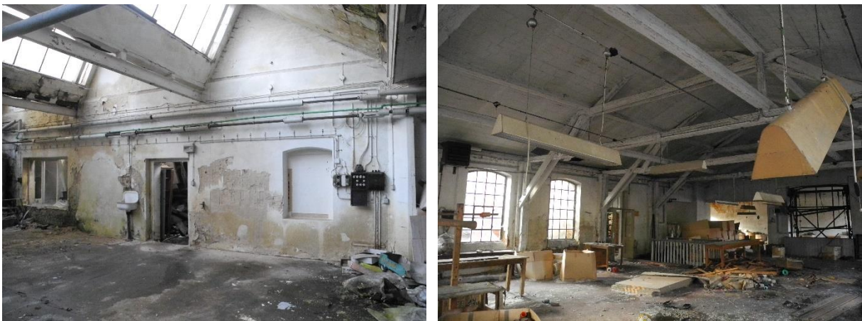
Abbildung 16: Innenansichten Nebengebäude ehem. Textilfabrik
