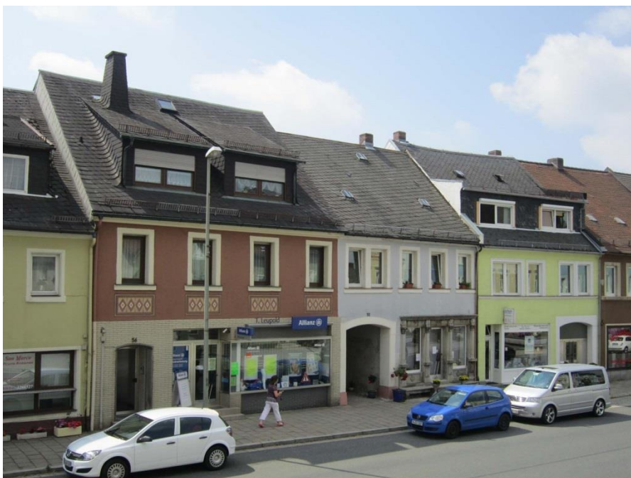
geschlossene, traufständige Bauweise in der Hauptstraße
