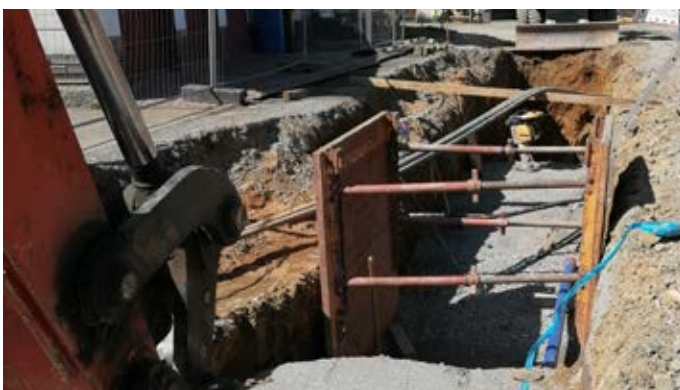
Im Zeitplan liegen die Bauarbeiten für die Kanalerneuerung Gefrees Nord. Hier eine Bestandsaufnahme von der Baustellenbesichtigung am 22.04.2021 in der Friedrich-Ebert-Straße.
