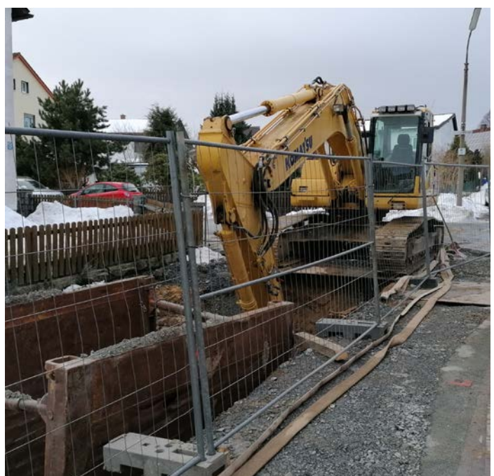
In der Friedrich-Ludwig-Jahn-Straße starteten die Bauarbeiten wieder. Foto: Stadt Gefrees
