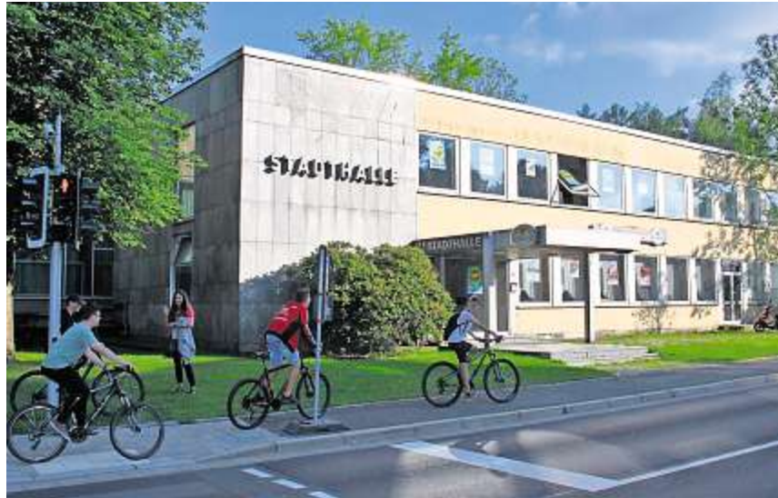
Um die Zukunft der Stadthalle Gefrees ging es in einer Bürgerwerkstatt. Foto: Judas
