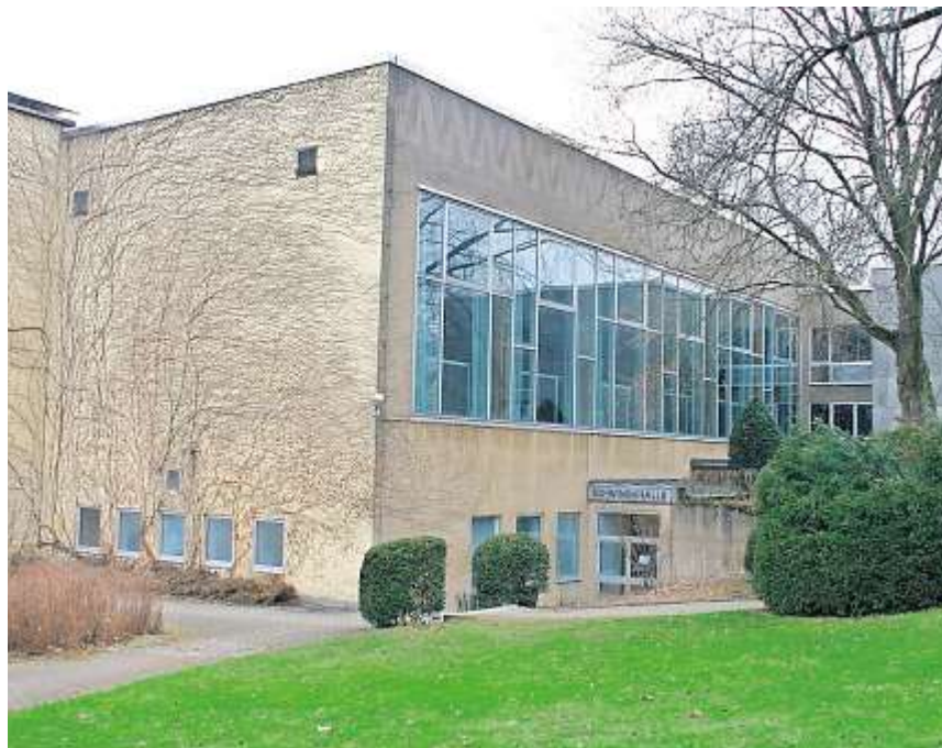
Wird bald die größte Baustelle in Gefrees sein: Die Stadthalle. Foto: Helmut Engel
