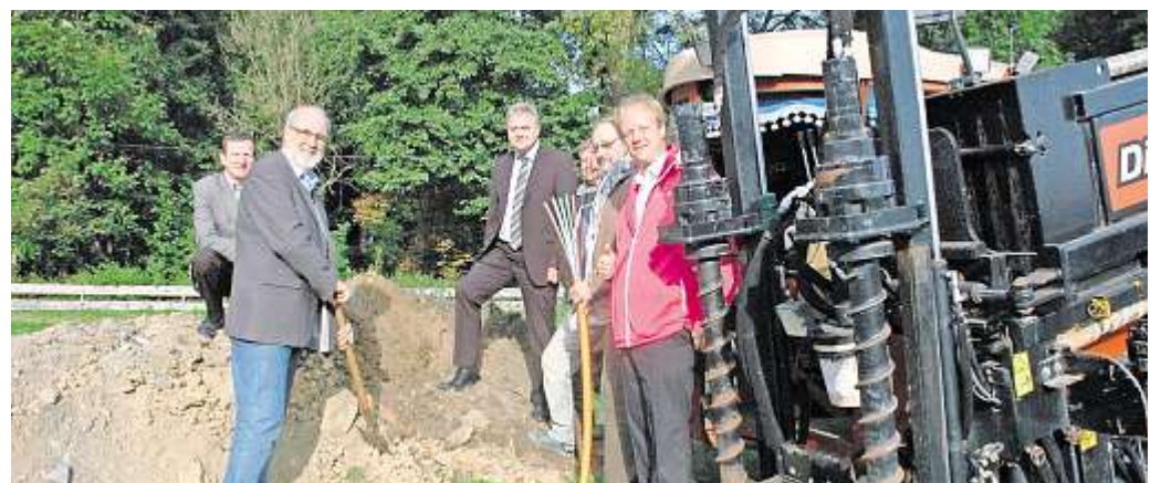
Mit einem symbolischen ersten Spatenstich wurde der flächendeckende Ausbau des Breitbandnetzes gestartet. Unser Bild zeigt (von links) Netzplanungstechniker Martin Reuther, Bürgermeister Harald Schlegel, Friedrich Weinlein von der Telekom, Carsten Vollhardt vom Bauunternehmen Bergert, Wolfgang Popp vom Bauamt und den Ansprechpartner der Telekom für den Infrastrukturvertrieb, Andreas Rudloff.
