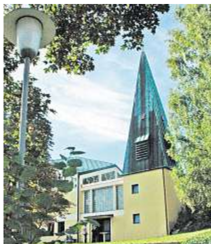
Bei der Sanierung vor sechs Jahren erhielt die Sankt-Josefskirche ihr heutiges Bild.
