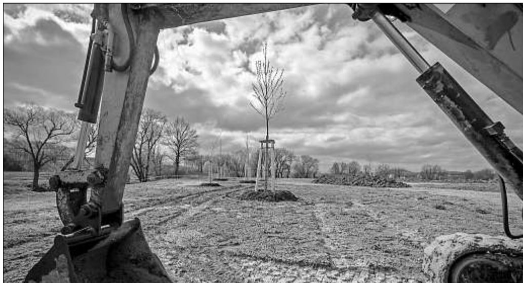
Ein Jahr vor der Eröffnung ist ein großer Teil des Geländes für die Landesgartenschau 2016 in Bayreuth noch eine Baustelle.
