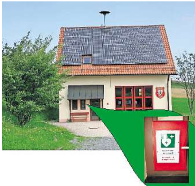
Der Standort des „Defis“ am Steiner Feuerwehrhaus ist deutlich gekennzeichnet, so dass er auch nachts leicht auffindbar ist.
