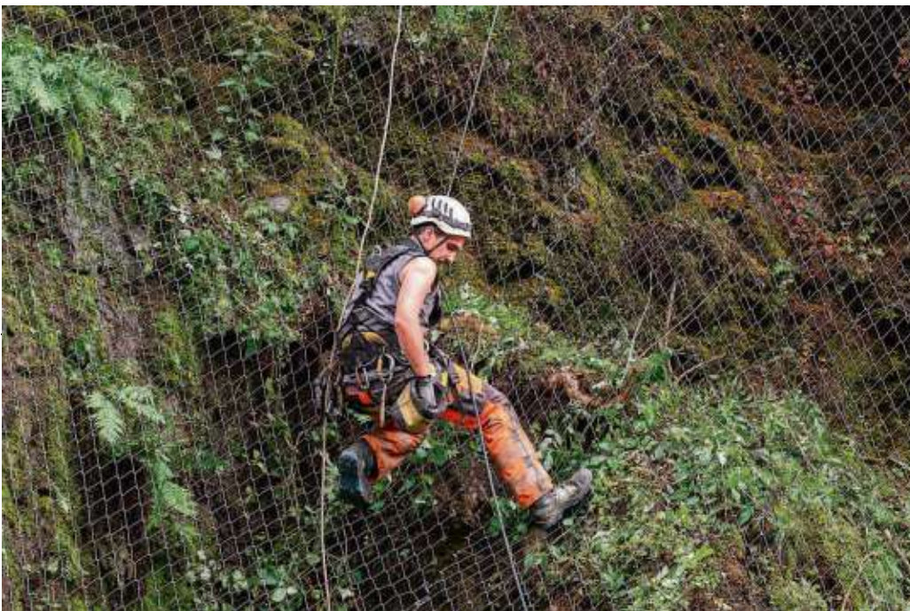
Abstürzende Steine und Felsteile gehören der Vergangenheit an. Unterhalb der Burgkapelle Stein wurde eine Felssicherung durchgeführt. Foto: ju
