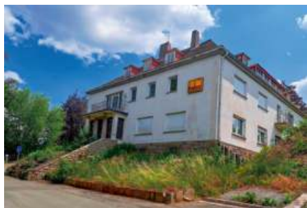
Das alte Helsa-Verwaltungsgebäude soll für das neue Pflegeheim abgerissen werden.
