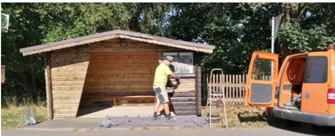
Bauhofmitarbeiter Christian Mauksch kümmert sich um die Renovierung der Buswartehäuschen
