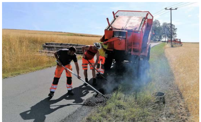
Führen derzeit Ausbesserungsarbeiten am Bankett durch: Die Bauhofmitarbeiter Peter Seuß, Christian Mauksch und Thomas Schlenk (von links)
