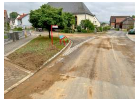
Streitau während der Aufräumarbeiten
